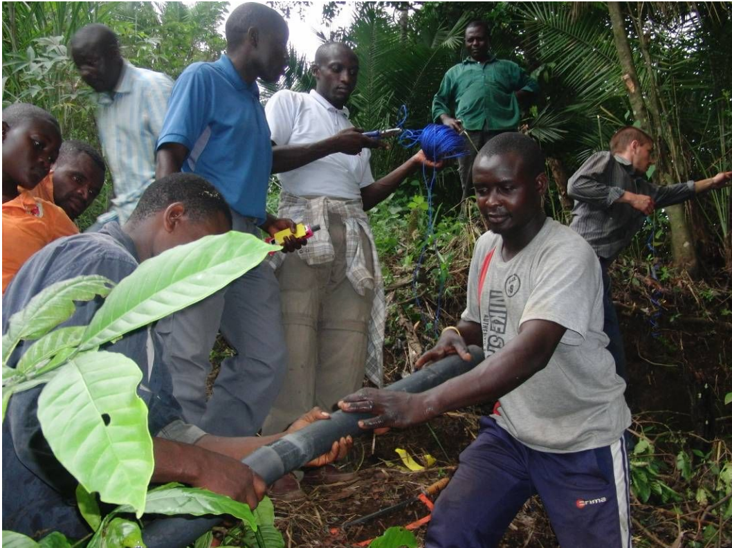
Bild 6: Verlegen von Rohren für die Wasserkraftanlage
