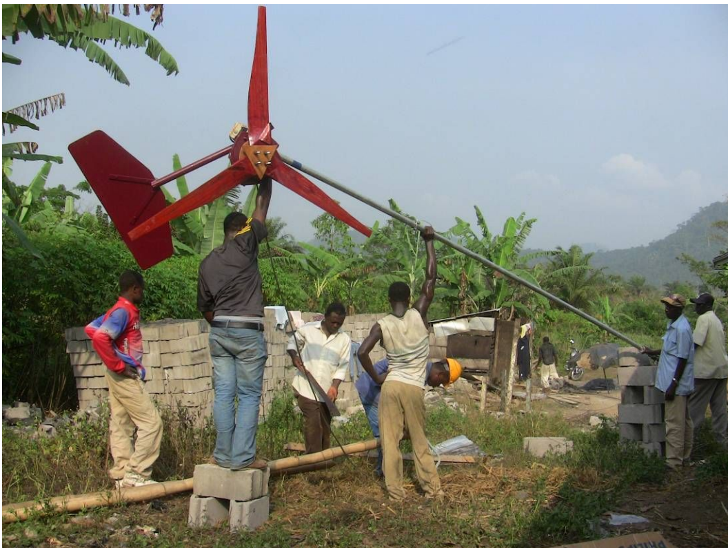
Bild 10: Errichtung der Windkraftanlage in Limbe
